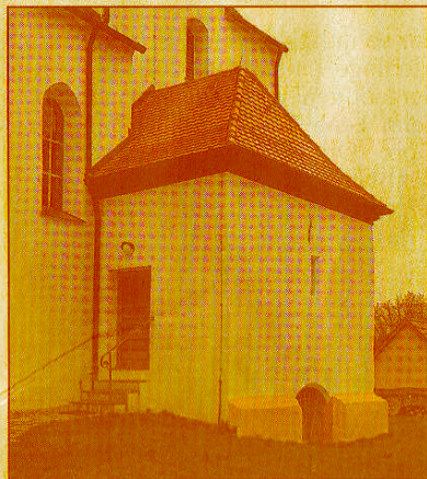
Das an die Kirche angebaute Beinhaus umfasste früher eine Gruft und darüber eine Kapelle.
